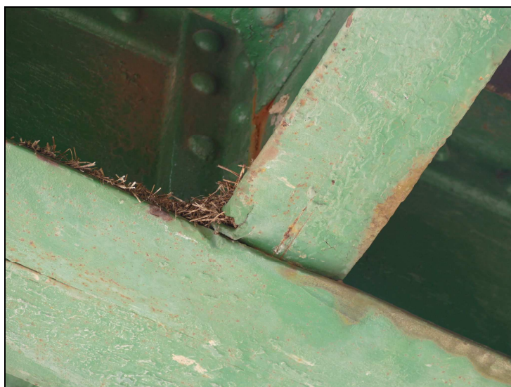
Obr. č. 2 – Konstrukce K 01 – levý podélník ve 3. poli – tržení dolního vnějšího krčního úhelníku + vrub v dolním úhelníku příčnicku č. 4
