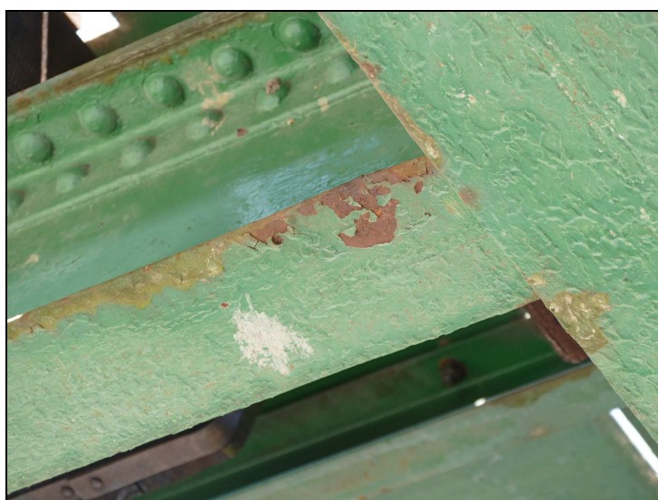
Obr. č. 3 – Konstrukce K 01 – pravý podélník ve 3. poli – deformace dolního vnitřního krčního úhelníku
