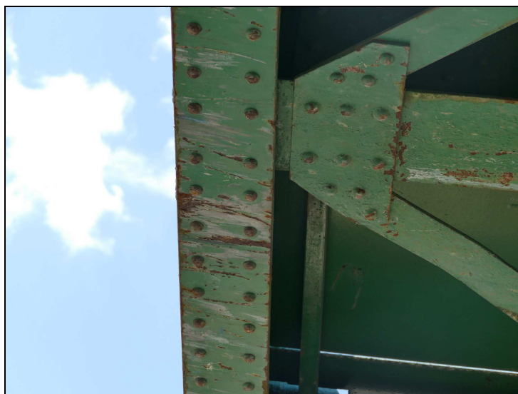
Obr. č. 1 – Konstrukce K 01 – dolní pásnice levého hlavního nosníku ve 3. poli – rýhy a vruby od projíždějících vozidel
