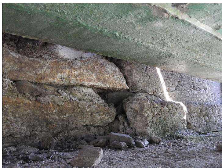
Obr. č. 5 – Opěra O 02 – závěrná zeď – vypadané spárování v pravé části
