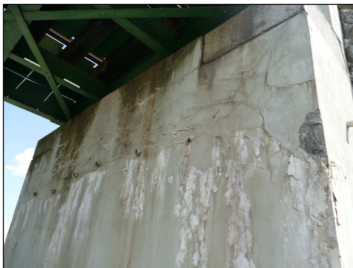
Obr. č. 4 – Opěra O 01 – dřík – popraskaná povrchová úprava s průsaky vody a výluhy pojiva
